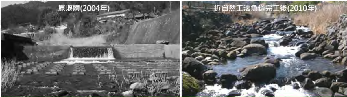
日本岩岳川篠瀨堰-近自然工法改善 (不拆堰的前提下來改善)
