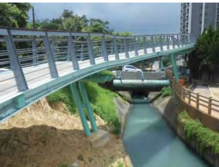
石門大圳休憩路廊串連工程
