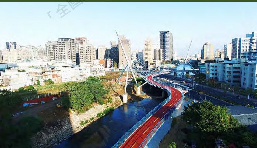
桃園市南崁溪經國二號橋上游至大檜溪 橋下游護岸整建暨水域營造
